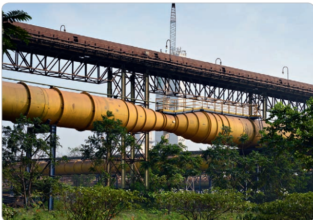
Obr. 3 Meranie prietoku vo veľkom: prietok plynov prichádzajúcich do procesu tavenia sa meria cez obrovské Venturiho trubice
