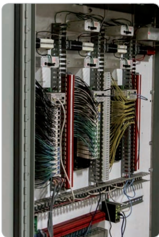
Obr. 2 Modernizácia V/V a riadenia s moderným hardvérom Opto 22 SNAP PAC
