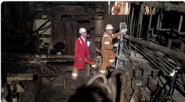
Obr. 7 Výškové zameranie valcov dosadania sekcií liniek L1 a L2 ZPO2
