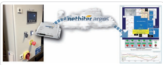
Obr. 1 Komunikačná brána Netbiter je pripojená na PLC Rockwell Automation. Užívateľia môžu k zariadeniam budovy pristupovať cez www.netbiter.net
