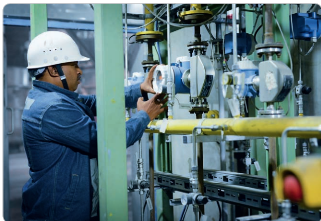
Obr. 1 Spoločné technológie merania: oceliareň Vijayanagar má nainštalovaných viac ako 12 000 meracích prístrojov Endress+Hauser
